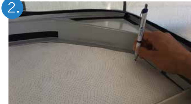
2. Tracer les 4 points indiqués sur le gabarit.
