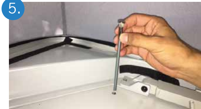
5. Insérer les tiges filetées
